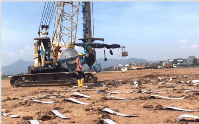
Pemasangan atau penanaman PVD ke dalam tanah menggunakan *crawler crane*. Untuk membantu penyerapan air yang keluar dari PVD, maka di atas permukaan ditambahkan timbunan tanah dan menggunakan PVD untuk mengalirkan air dan udara ke tempat saluran yang telah disiapkan.
