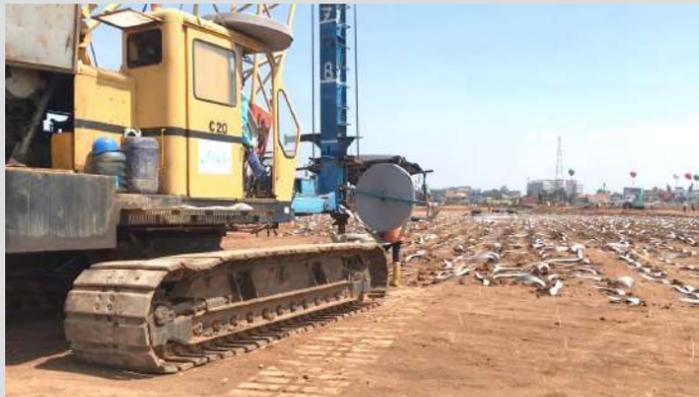
Pematangan lahan kawasan Podomoro Park menggunakan metode PVD (*Prefabricated Vertical Drain*) dan PHD (*Prefabricated Horizontal Drain*). Metode ini merupakan teknik pemadatan tanah dengan cara mengurangi kadar air dan udara dalam tanah.
