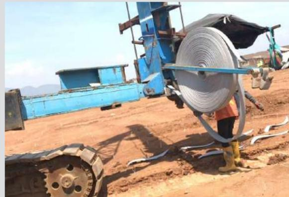
PVD berupa lembaran pita plastik untuk drainase vertikal yang berukuran panjang, kombinasi antara bahan inti polypropylene berkekuatan mekanik tinggi dan lapisan pembungkus dari bahan geotekstil.
